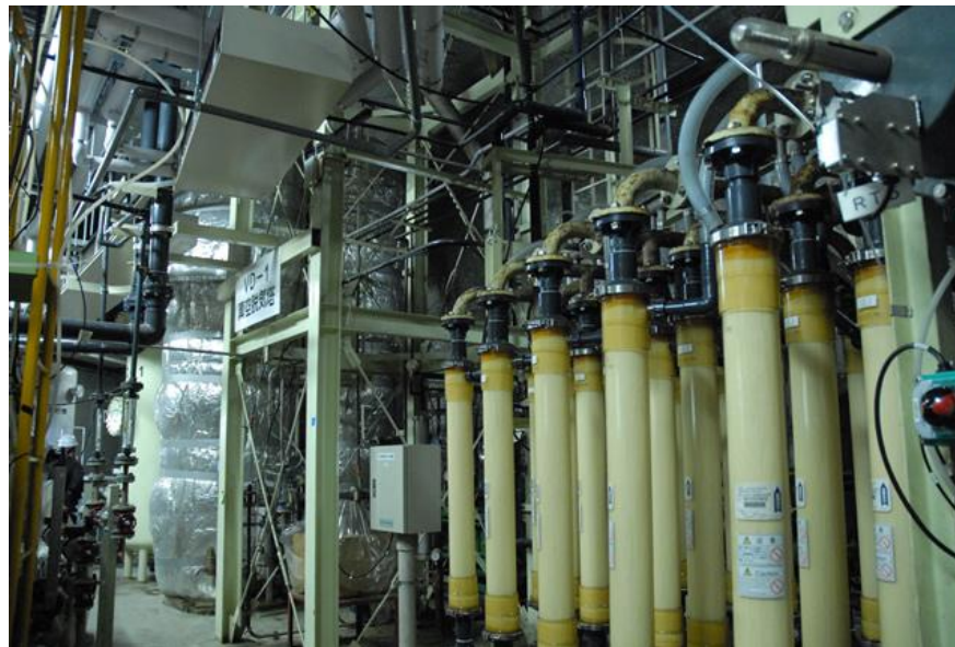
純水製造装置
