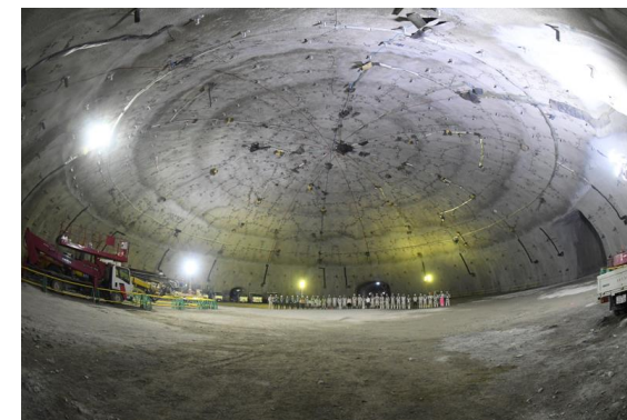
本体空洞ドーム部
