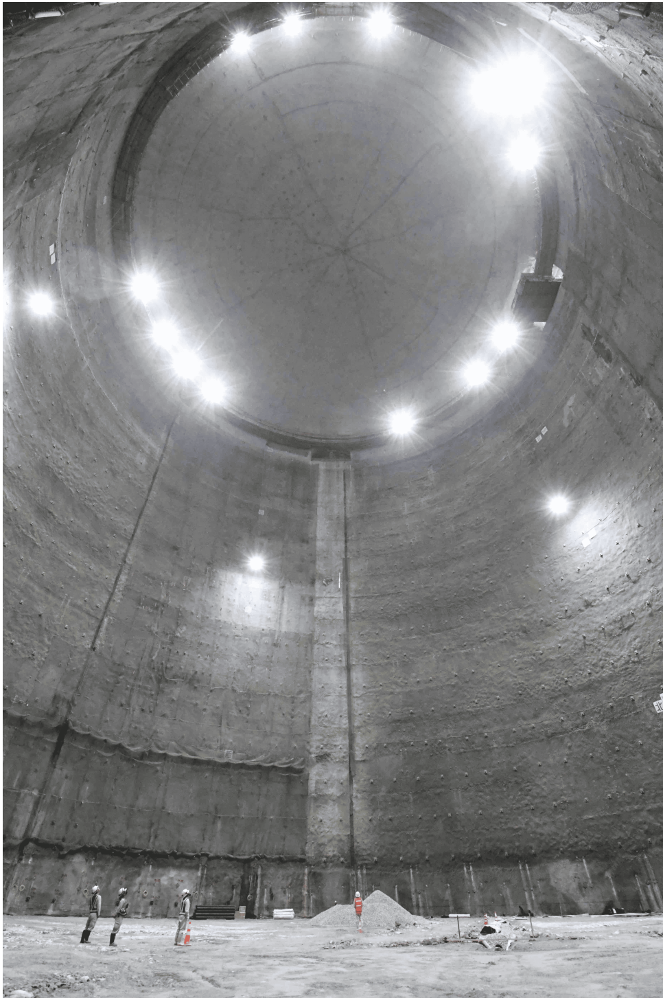
図 2.18: 空洞掘削が完了した HK 空洞の写真。[42] より
