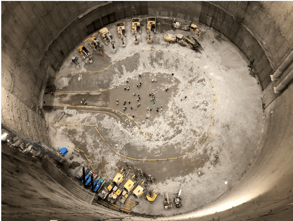
図 2.17: HK 空洞掘削完了を記念する、関係者見学会の様子。空洞の最上部から撮影したものであり、写真に写る人の大きさから空洞の大きさを体感できる。当時最底部の掘削が完了しておらず、中心部以外が1 m ほど高くなっており、まだ役目の残っている重機が並んでいる。
